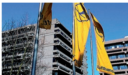
Das „alte“ Seeheim vor dem Abriss 2006
